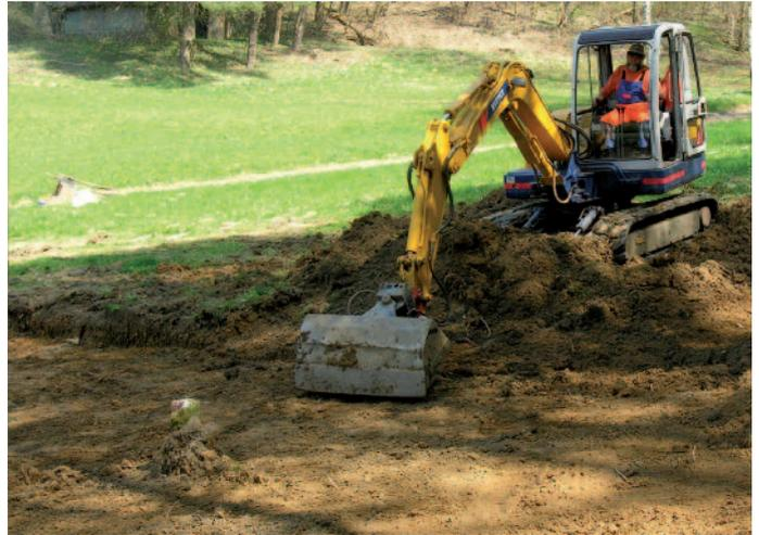
*Mit dem Bagger wird die meist zwischen 10 und 20 cm dicke, dunkle Humusschicht abgetragen.*
